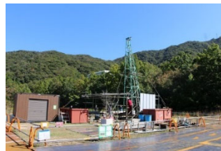
「もんじゅ」敷地内におけるボーリング調査 (2021年10月)
